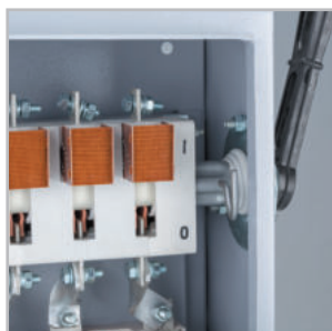
Устройство запирания дверцы.
