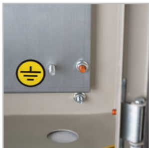
Шпилька заземления на монтажной панели.
